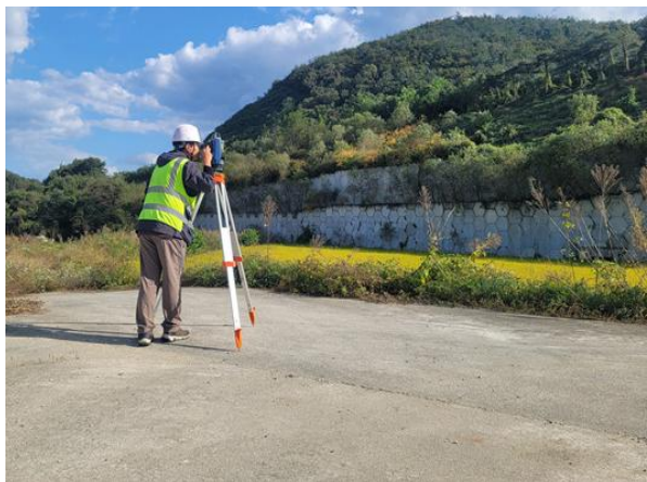
광파기를 이용한 측량 작업
