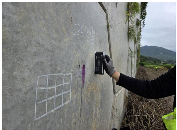
경사계를 이용한 경사도 측정
