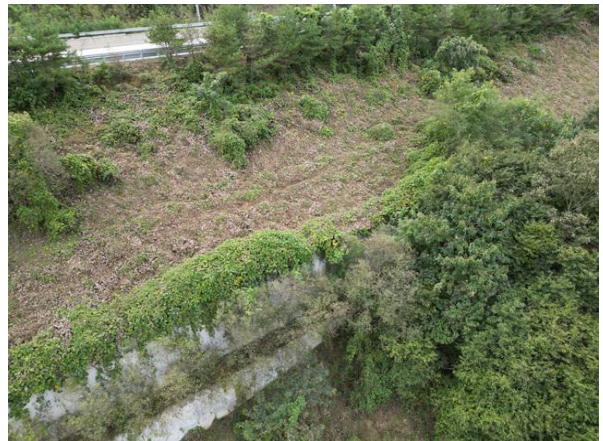
상부 성토부 전경
